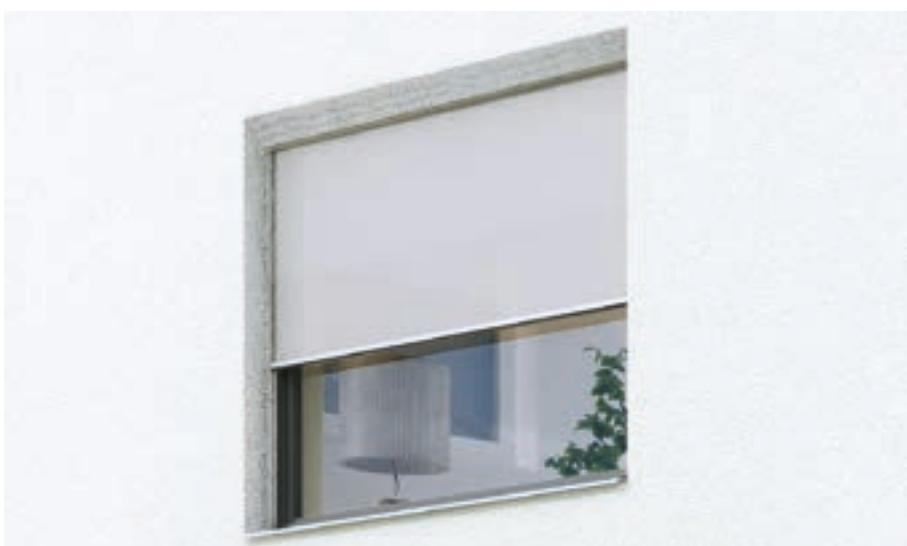
Einbauvariante mit Unterputzkasten
